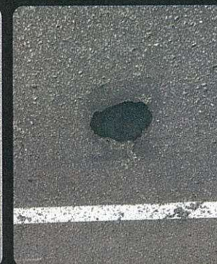
車道ポットホール補修
