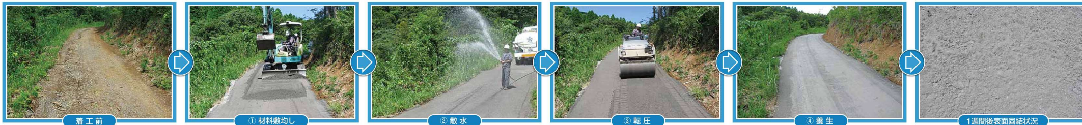
図2：施工フロー（林道の舗装例）
