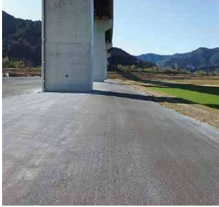
写真 8：高架下防草対策
