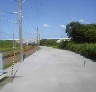
写真 5：縦路脇管理用地防草対策
