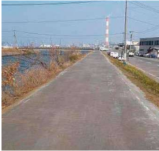
写真 4：河川沿岸天端管理道路
