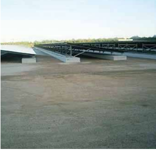
写真 7：ソーラー発電所防草対策
