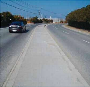
写真 3：中央分離帯防草対策
